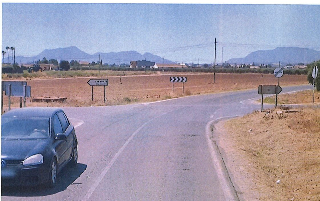
Intersección de la E-33
